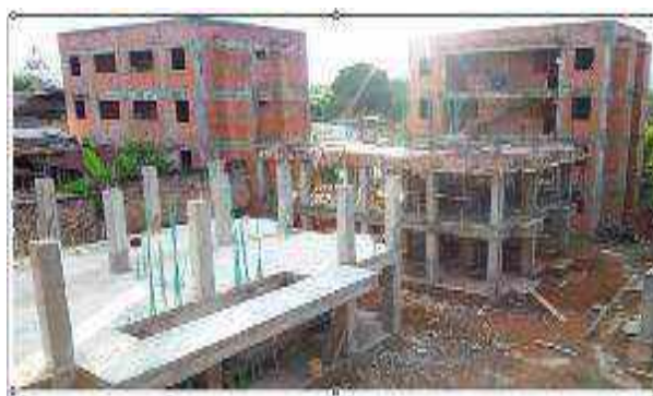
Placas y columnas fundidas
