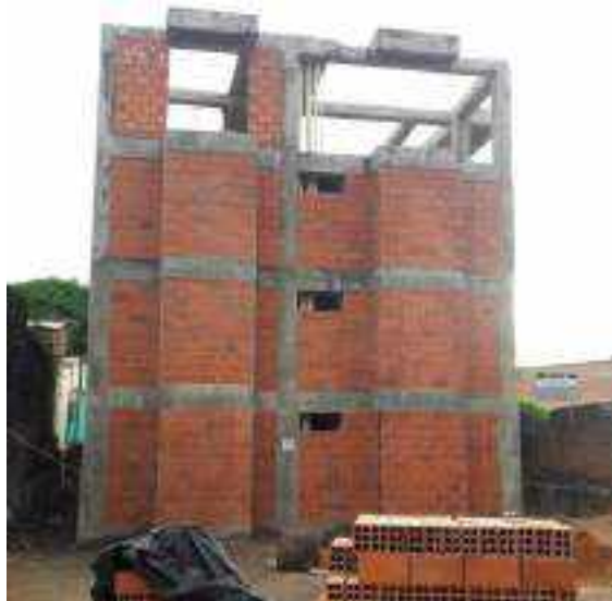
Mampostería torre A
