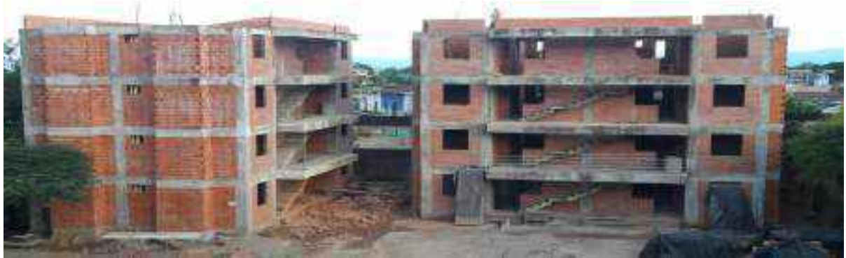
Construcción cuchillas torre E y F
