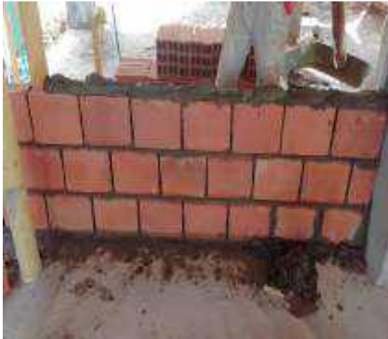
Inicio pega de bloque torre A
