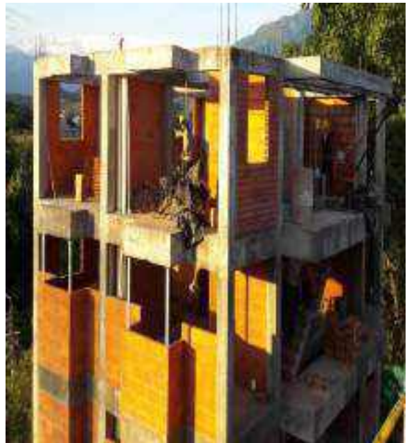
Mampostería torre B piso 3 y 4
