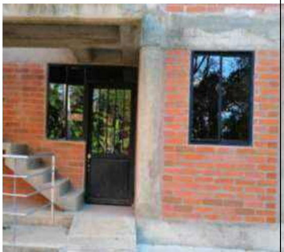
Instalación de vidrios
