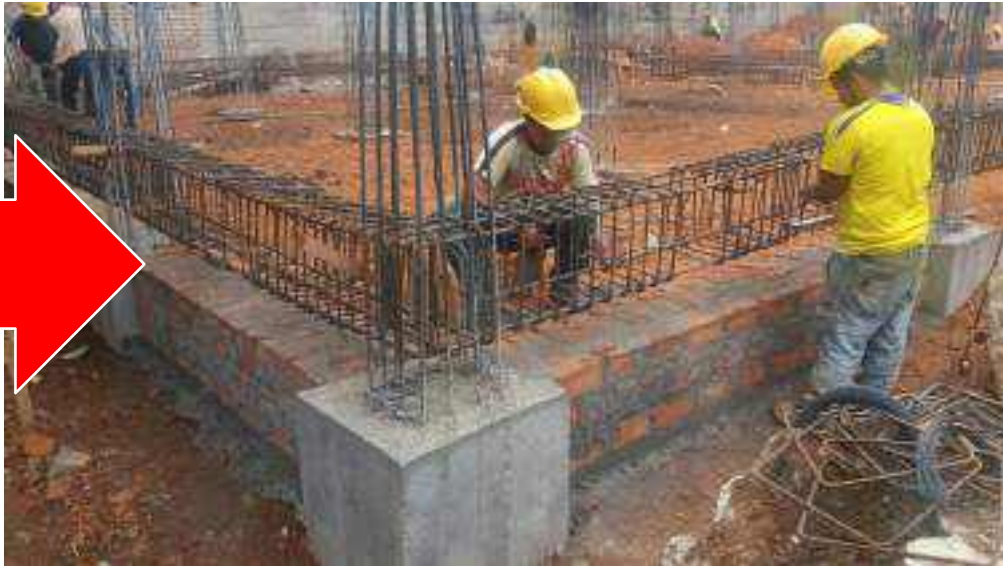
FOTO 8: muro en ladrillo tolete, Se evidencia los compromisos pactados en el acta No. 2
