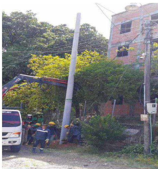
Instalación de postes
