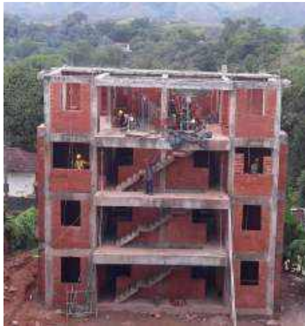
Mampostería torre B
