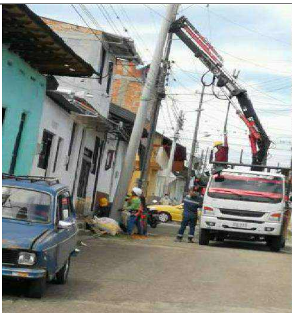
Instalación de postes
