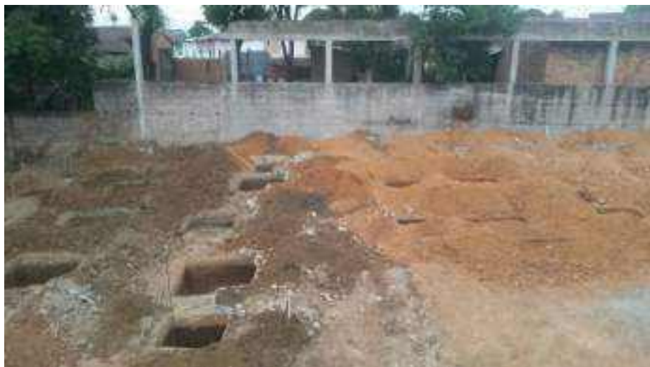
FOTO1: Excavaciones torre F y Torre E En la imagen se puede observar la diferencia del material en cada una de las torres.
