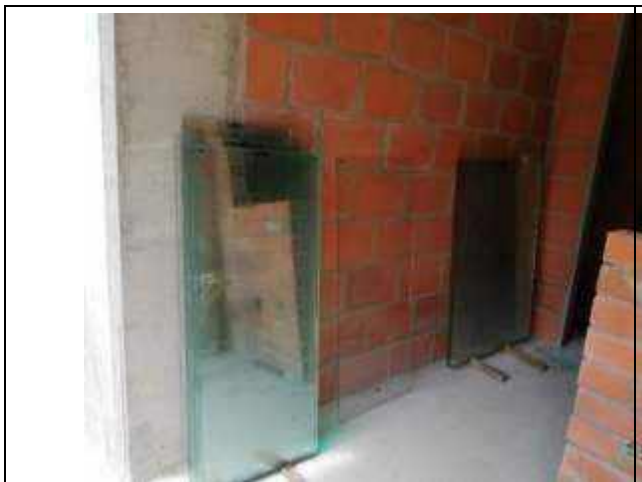
Vidrios para instalación
