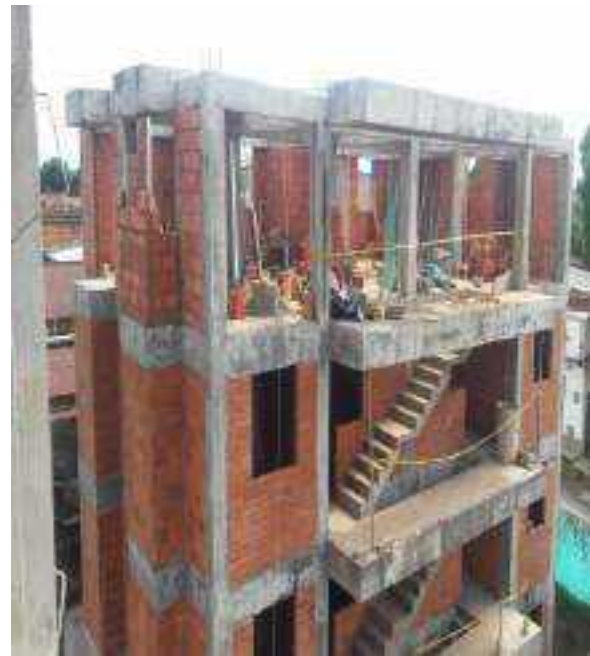
Mampostería torre A
