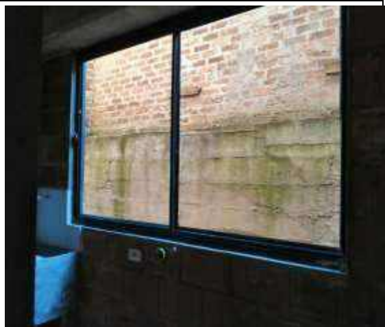
Instalación de vidrios
