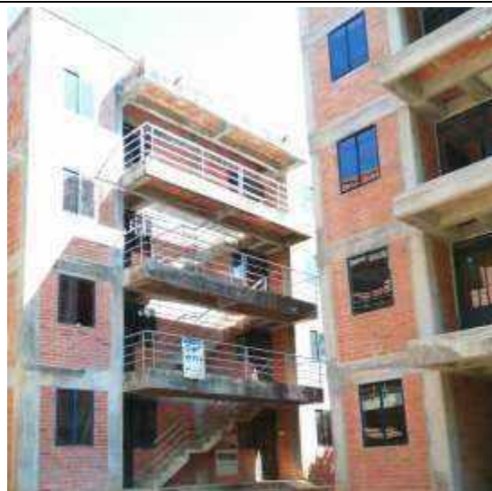
Instalación de vidrios
