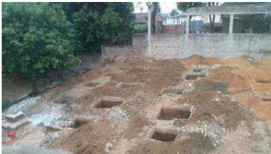
FOTO1: Excavaciones torre F y Torre E En la imagen se puede observar la diferencia del material en cada una de las torres.
