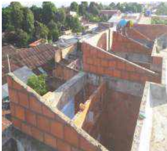
Construcción cuchillas torre E
