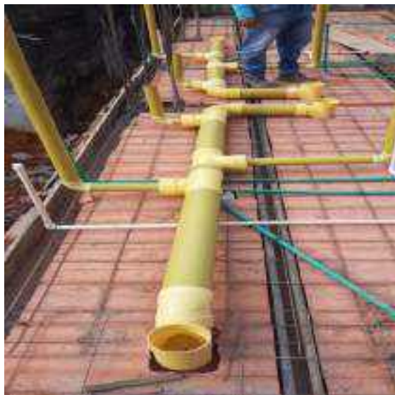
Instalación tubería segundo nivel
