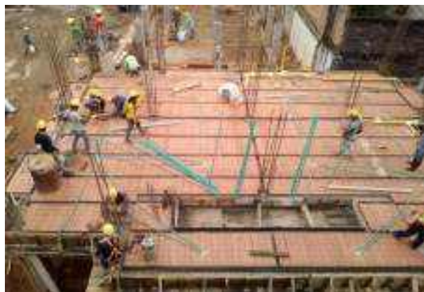
Construcción placa de entrepiso
