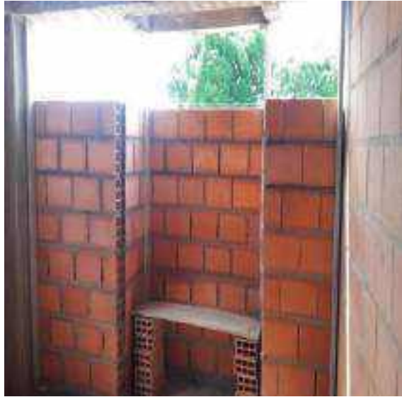
pega de bloque zona closet torre B
